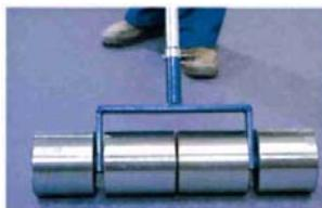
Разделку и сварку швов можно производить только после полного схватывания клея. В зависимости от марки клея (см. также рекомендации производителя клея), температуры и влажности помещения, этот процесс может продолжаться несколько дней.
