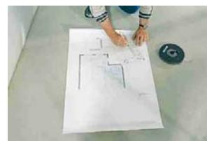
Перед укладкой рулоны следует перемотать лицевой стороной внутрь, ввиду свойства этого натурального покрытия при укладке на специальный клей для натурального линолеума с малым содержанием воды несколько расширяться в поперечном направлении и сужаться в продольном. Материал следует отрезать с небольшим запасом.
