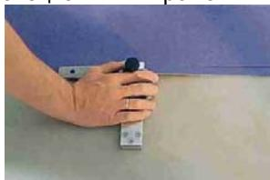
Вторую кромку можно обрезать также кромочным ножом, положив рулоны внахлест. В больших помещениях после нанесения клея кромка верхнего материала размечается специальным комбиразметчиком вдоль уже приклеенного материала и дорезается крючкообразным ножом.
