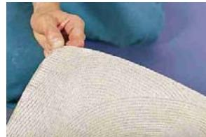
Для укладки натурального линолеума DLW необходимо использовать зубчатый шпатель B1 (с большим зубом, чем у шпателя для нанесения клея при работе с ПВХ покрытиями).
